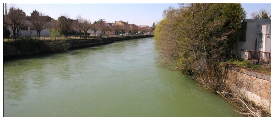
Photo 1 : L'Aube à Arcis-sur-Aube (Source : BE JC)
