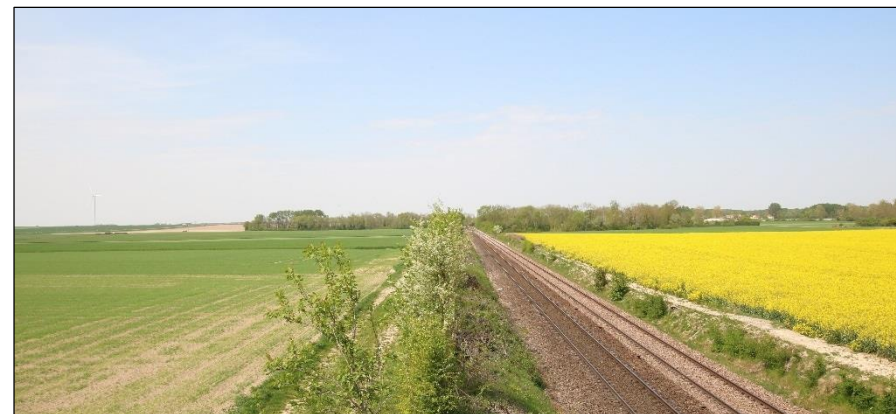
Photo 15 : Voie ferrée de la ligne TER Paris Est - Belfort, à Payns (Source : BE JC)
