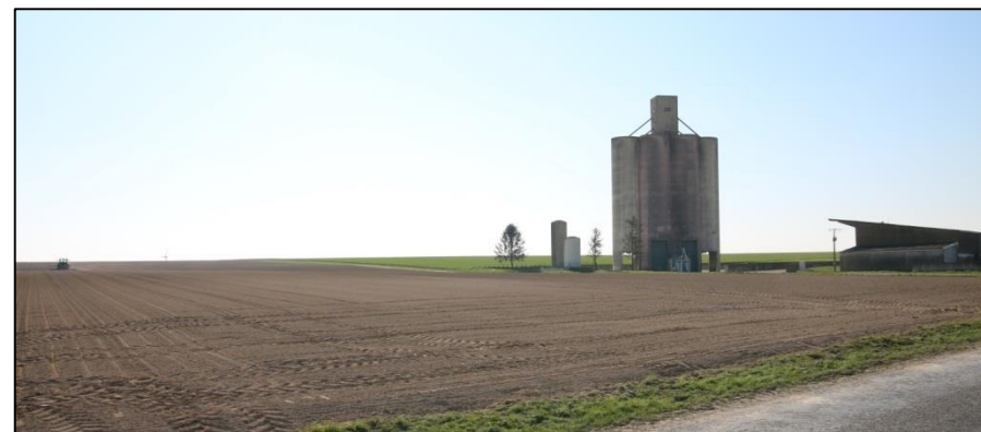
Photo 3 : Silo céréalier au Sud d'Envy (Source : BE JC)
